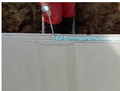
Uložení jímky, očištění okrajů od nečistot a nanesení montážní studnařské pěny
