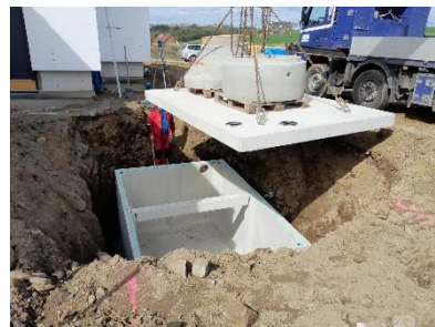
Uložení jímky, očištění okrajů od nečistot a nanesení montážní studnařské pěny
