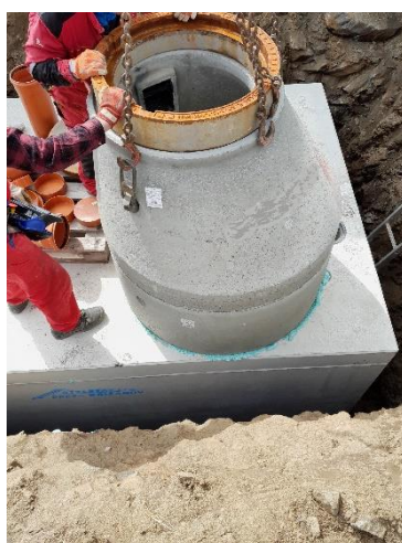
Uložení jímky, očištění okrajů od nečistot a nanesení montážní studnařské pěny
