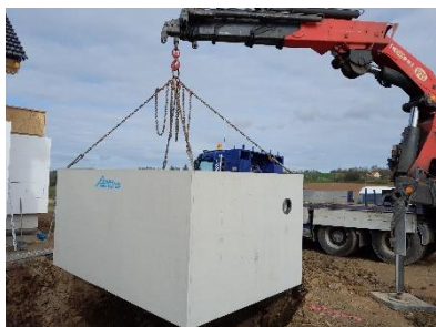
Uložení jímky, očištění okrajů od nečistot a nanesení montážní studnařské pěny
