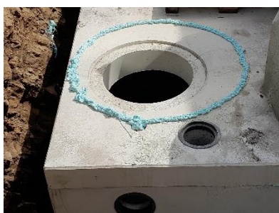
Uložení jímky, očištění okrajů od nečistot a nanesení montážní studnařské pěny
