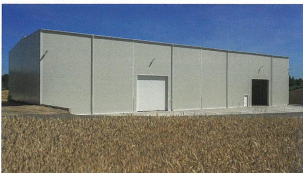
Hala s přípravou pro jeřábovou dráhu, délka 48 m, šířka 24 m, výška 8 m. Opěrné stěny do výšky 4 m, opláštění PUR panelem a skládaným střešním pláštěm v kombinaci se světlíkem. Doba výstavby na klíč je 7 měsíců.
