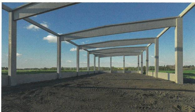
Skladovací hala délky 36 m, šířky 18 m a výšky 6 m – skelet vč. základových patek a základových prahů navržený k doplštění PIR panelem a skládanou střechou s krytinou PVC, vyrobený a namontovaný během 2 měsíců.
