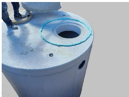
Nanesení montážní pěny pod kónusový díl a jeho osazení na zákrytovou desku a následné usazení poklopu do vrchního otvoru kónusu.
