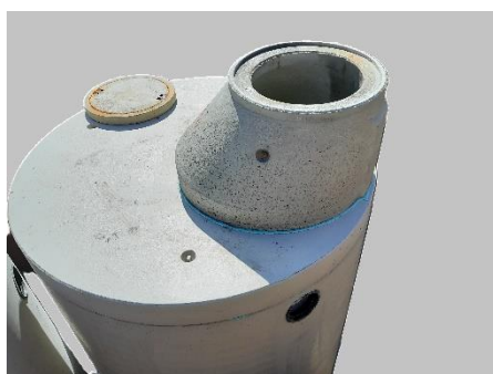
Nanesení montážní pěny pod kónusový díl a jeho osazení na zákrytovou desku a následné usazení poklopu do vrchního otvoru kónusu.
